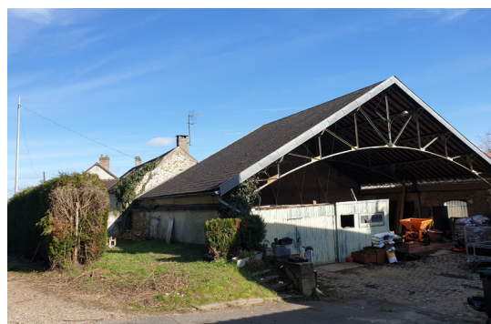
Hangar agricole existant (derrière la Mairie) Projet lieux de vie et logements solidaires
